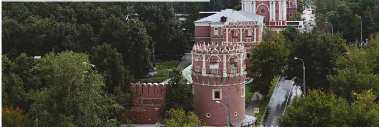
Стена с западными воротами. Вид со стороны Донской улицы в 1950 году и в настоящее время
