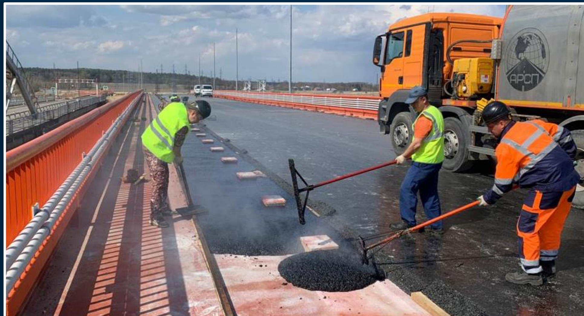
Асфальтобетонная смесь используется для создания верхних защитных слоев покрытия мостовых сооружений, выполняя так же функцию гидроизоляции.
