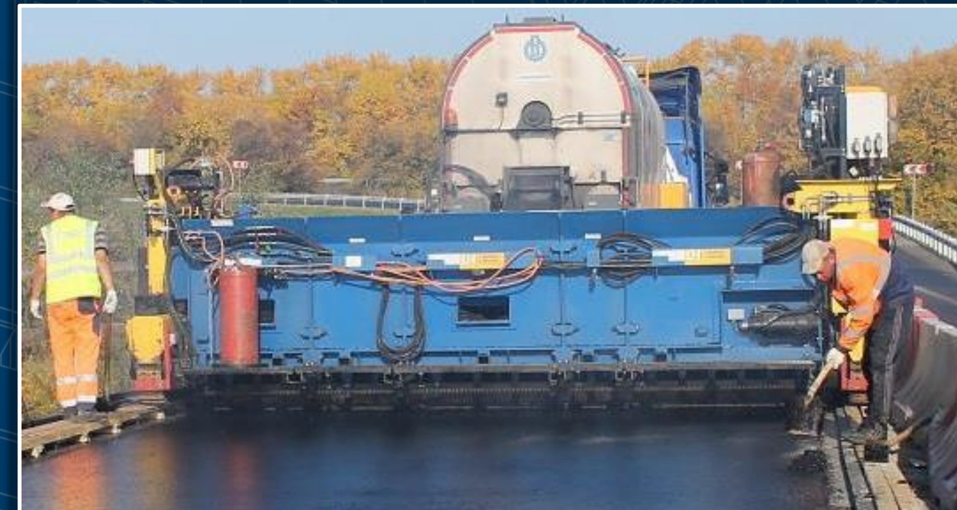
Асфальтобетонная смесь используется для создания верхних защитных слоев покрытия мостовых сооружений, выполняя так же функцию гидроизоляции.
