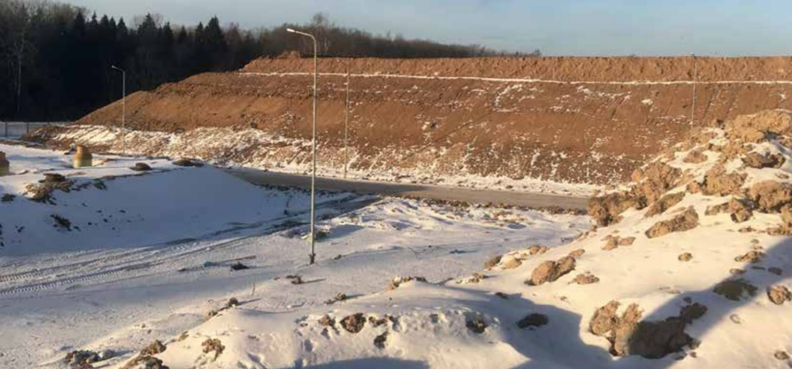
Вид на спланированный (отработанный) откос полигона ТКО, который впоследствии будет покрыт техногрунтом
