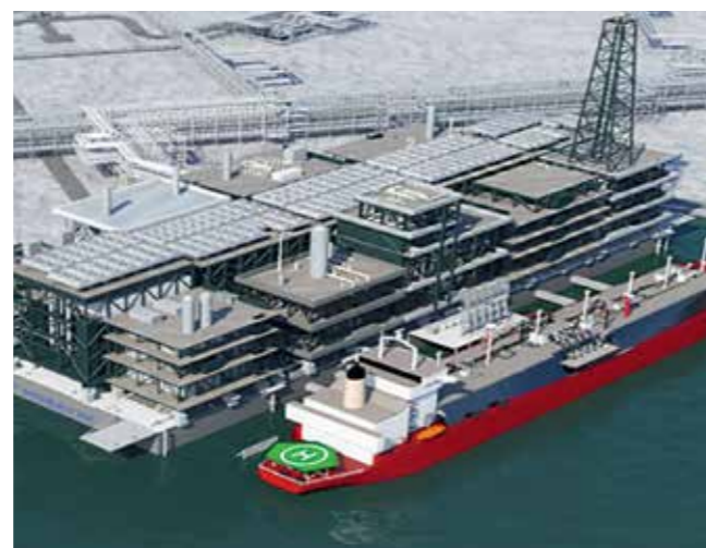
Рис. 5. Размещение технологических линий завода СПГ на основании гравитационного типа (источник — ПАО «НОВАТЭК»)
