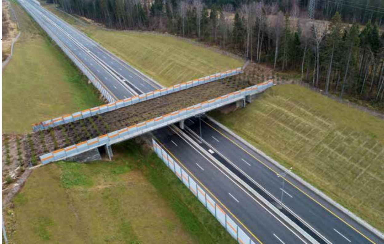
Первый экодук для перехода диких животных через Центральную кольцевую автодорогу (ЦКАД) возвели на участке третьего пускового комплекса в Солнечногорском районе Московской области. Это самый крупный из пяти экодучков и зверопроходов, построенных на ЦКАД-3, его длина около 100 м. (Фото предоставлено ГК «Автодор»)
