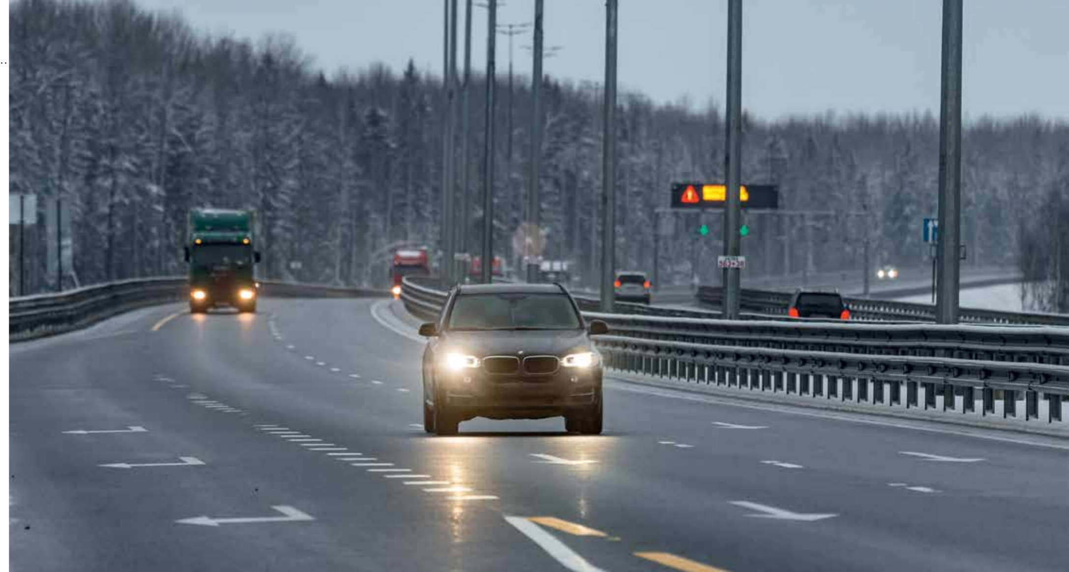
Участок скоростной магистрали М-11 «Нева» 543–684 км в Новгородской области. Фото предоставлено ГК «Автодор»
