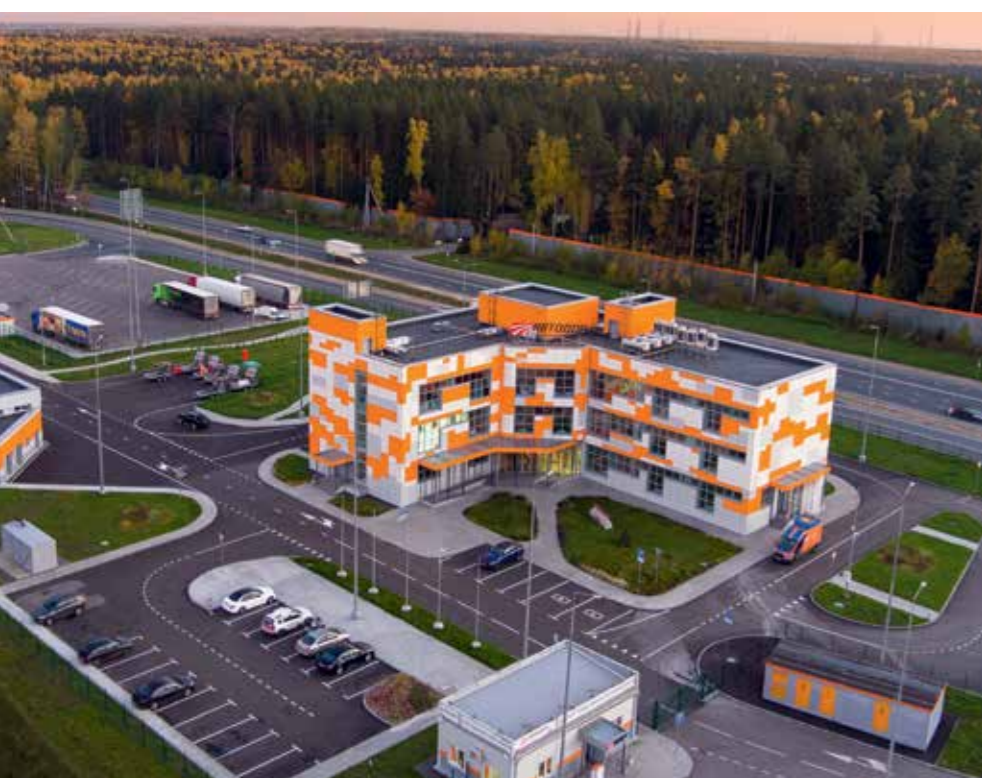
Центральный пункт управления ЦКАД
