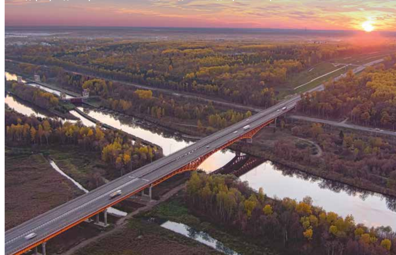
Мост через канал имени Москвы — самое масштабное из всех сооружений Центральной кольцевой автомобильной дороги. Его длина составляет почти 1,5 км
