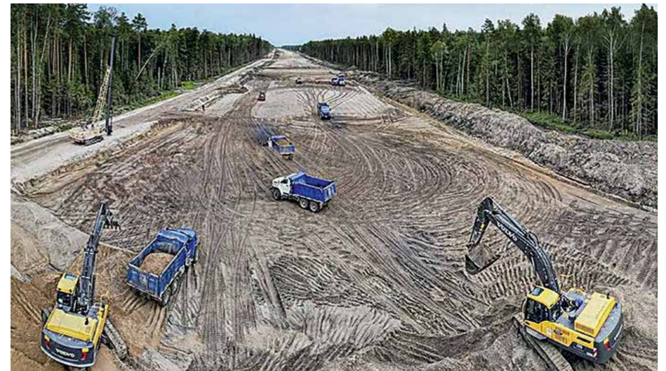
Подготовка территории строительства М-12 на 4-м этапе (Владимирская область). Фото ДСК «Автобан»
